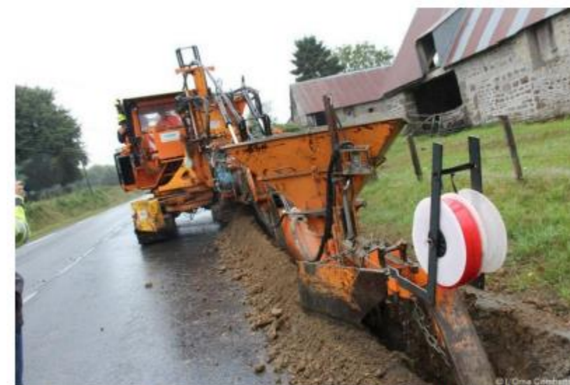
Photographie 67 : Illustration d'un forage dirigé pour l'enterrement d'une ligne électrique le long d'une route (Source : SIMETHIS)
