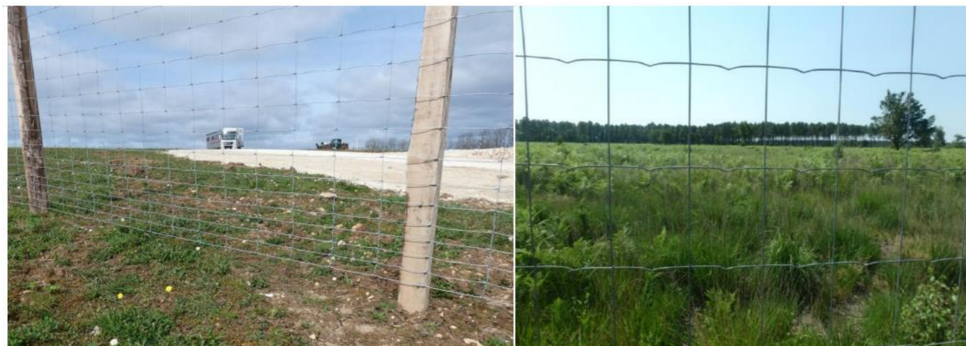
Photographie 74 : Exemple de grillage adapté à la circulation de la petite faune (Source : SIMETHIS)
